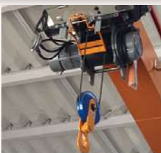
ホイスト設備工事 (各種クレーンの製作)
